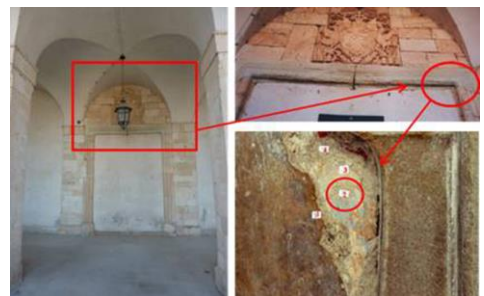
Fig. 9 - Portale d'ingresso e punti di prelievo
