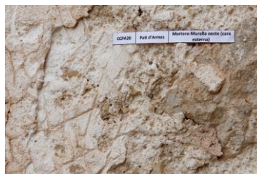
Fig. 9- Muestra CCPA20: mortero con incisiones romboidales para mejor agarre de la capa de revestimiento.
