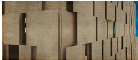
Fig. 10-Detalle del aplacado cerámico del nuevo restaurante y los nuevos kioscos.
