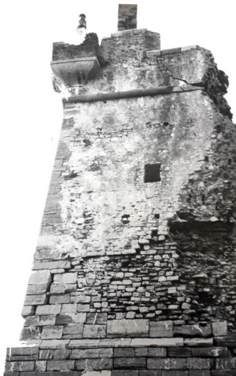
Figura 2 – Particolare di Torre Scola prima dei restauri degli anni Settanta. Evidenti i danni alla cortina muraria e lo sfalsamento di piano di parte della stessa a causa dell'esposizione del 1799. (da Marmori F., op cit. , 1973, pp. 672)
