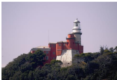
Figura 4 – Vista del complesso del Faro sull'Isola del Tino. Da notare il basamento della torre del faro, elemento dai caratteri costruttivi tipicamente seicenteschi. (da www.staticflickr.com )
