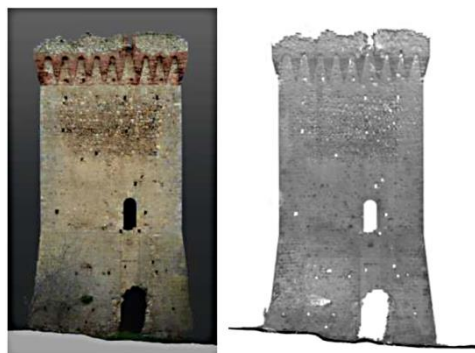
Fig. 5- Resa da nuvola di punti e fotopiano del fronte ovest della torre (M.V. Salvatori, 2017)
